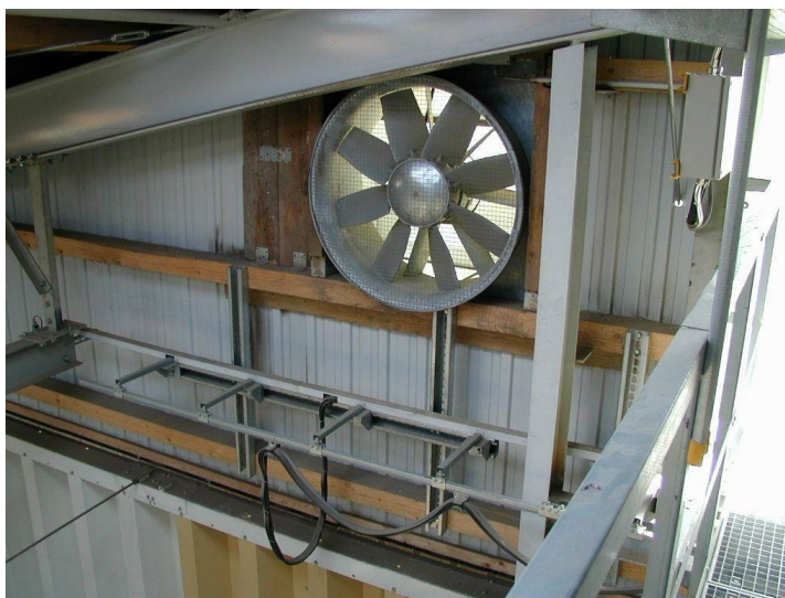
Figura 4.17. Alto flujo de aire, ventilador de escape de baja potencia eléctrica que ventila el aire del espacio de cabeza de un edificio de almacenamiento plano.
